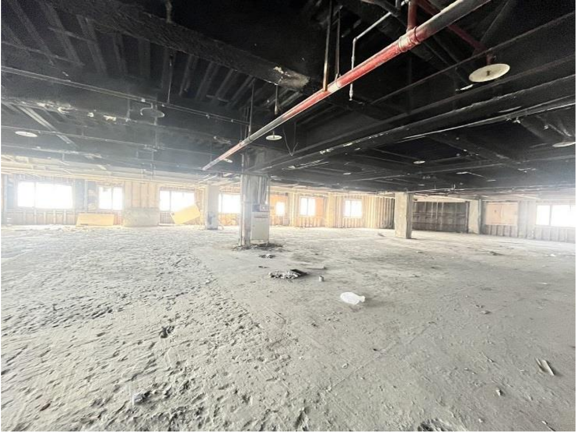
▲桃園區建物照片
