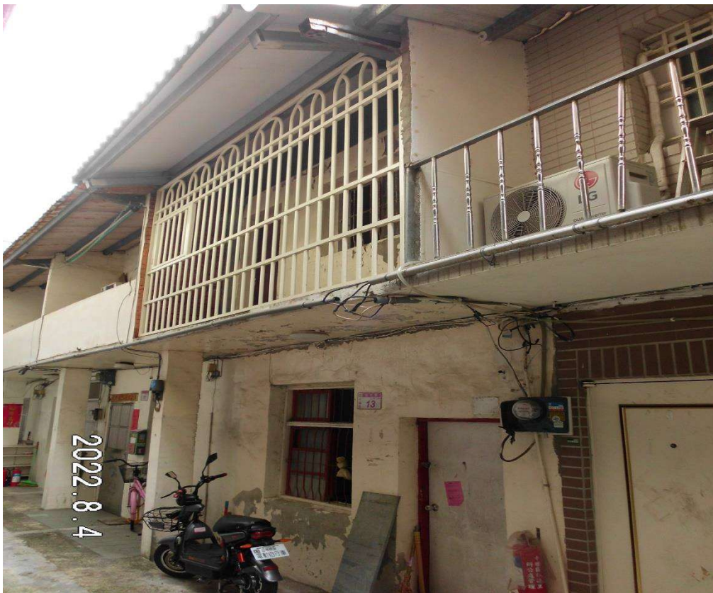
▲中壢區 2 層樓加強磚造房屋
