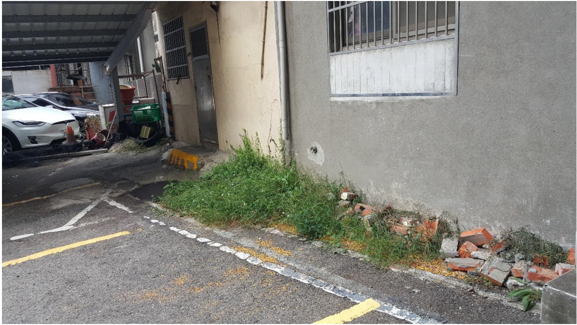
▲ 復興停車場內土地(中壢區中台路 10 號旁)
